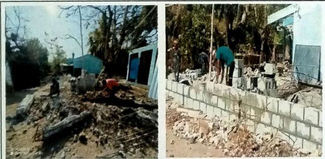
Foto 3: TRABAJOS EXTERIORES Proceso de levantado de block pomez.
