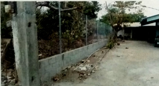
Foto 11: TRABAJOS EXTERIORES , -Vista lateral izquierda de muro de con tubo HG Y malla calibre 12.
