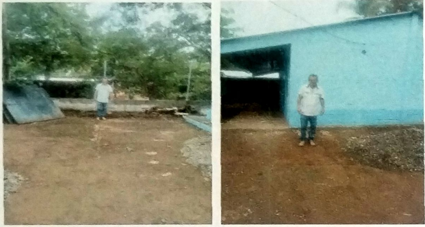
Foto 7: VISTA FRONTAL DE MODULO A DE AULA.
