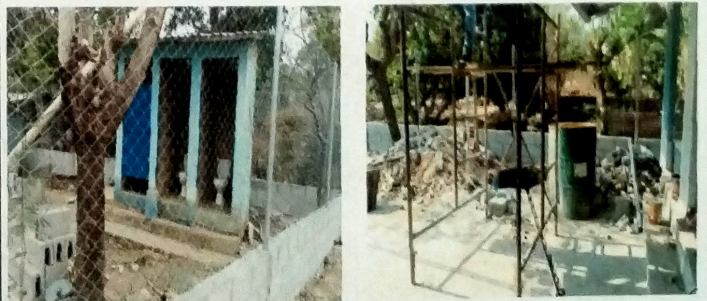
Foto 12: TRABAJOS EXTERIORES , -Vista de muro de block vista lateral derecha y frontal con tubo HG Y malla calibre 12.
