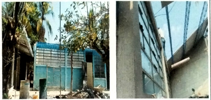
Foto 8: MODULO A Vista Frotal de desmontaje de lamina existente.
